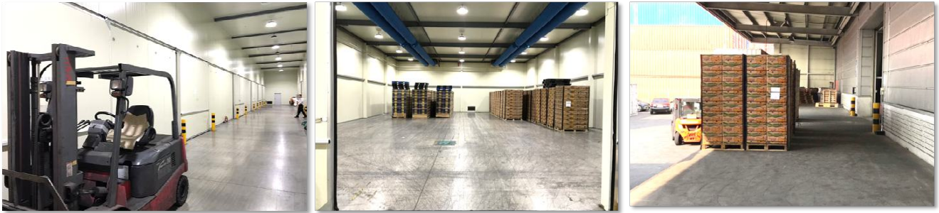
[ 냉장 정온 창고시설 전경 및 내부 모습 ]
